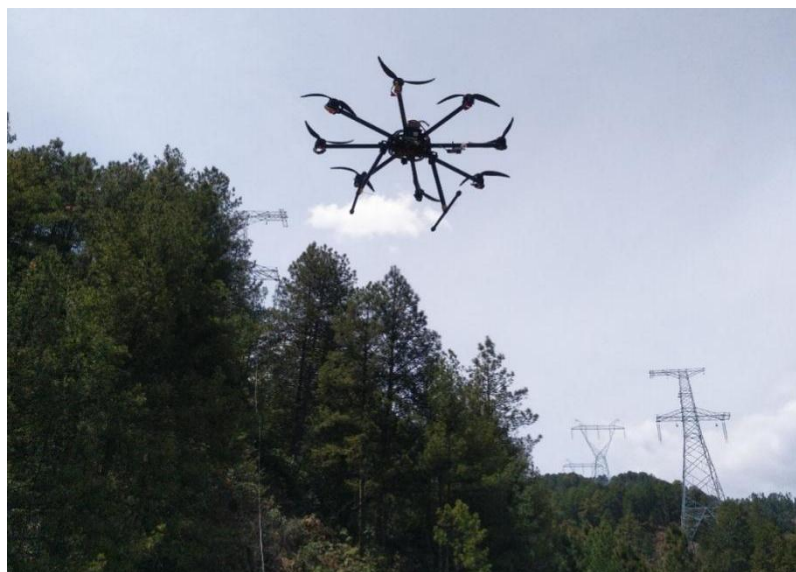
图 2-8 无人机放线施工示例
