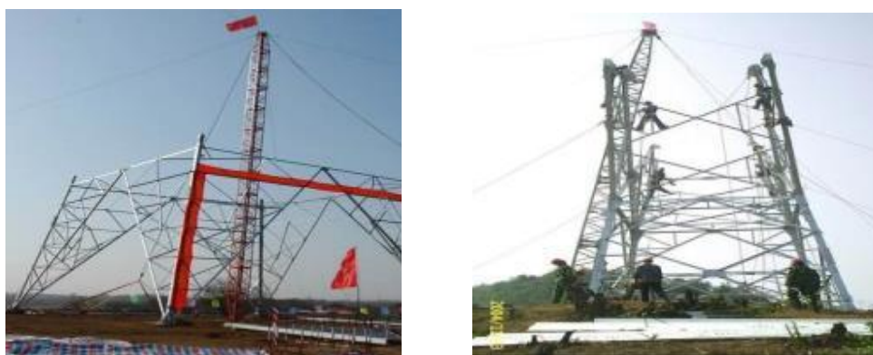
图 2-7 线路工程铁塔组立现场影像示例
