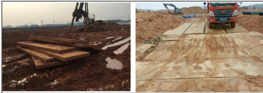
图5-3 临时道路路基箱铺设实例示意
