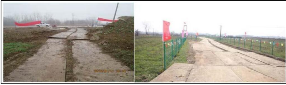
图5-2 临时道路铺设钢板实例示意
