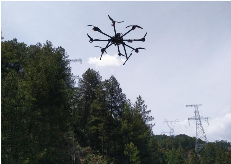
图 3.1-6 无人机放线施工示例
