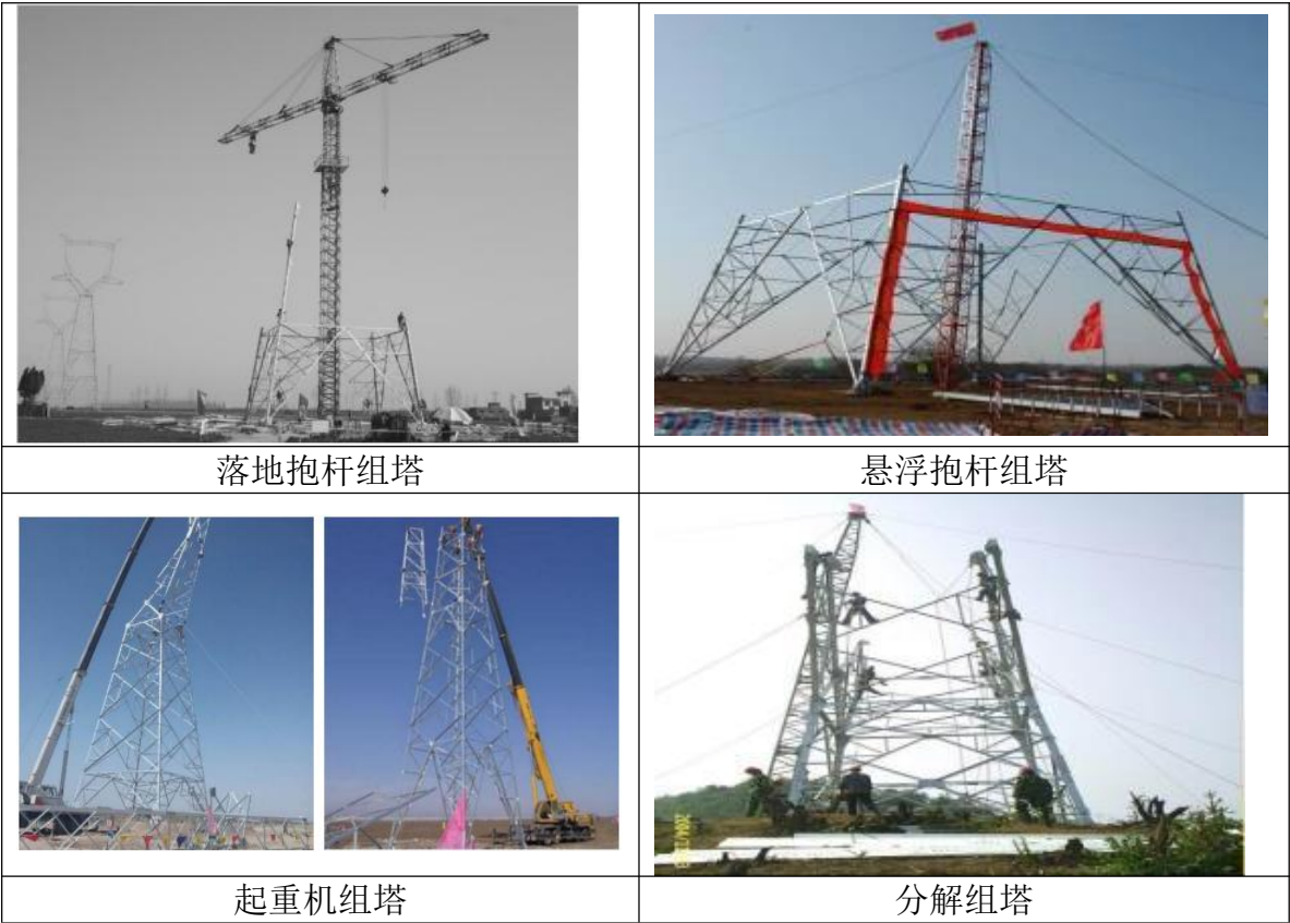
图 3.1-5 线路工程铁塔组立现场影像示例
