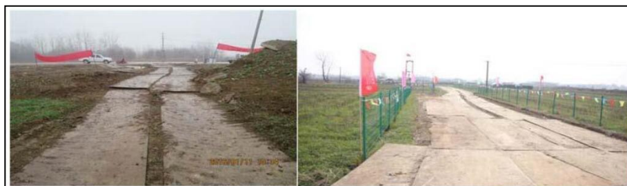
图7.1-4 临时道路铺设钢板实例示意
