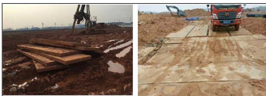
图7.1-5 临时道路路基箱铺设实例示意
