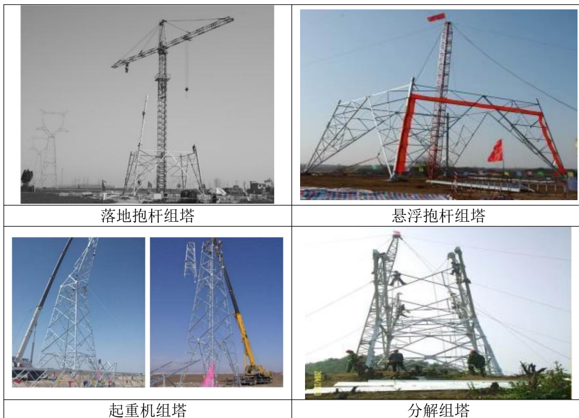
图 3.1-1 线路工程铁塔组立现场影像示例
