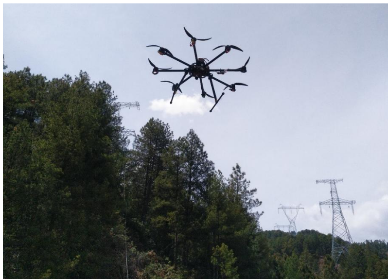
图 3.1-2 无人机展放导引绳施工工艺示例
