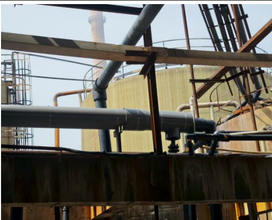
攀渝钛业界内废稀硫酸双层套管及导流管
