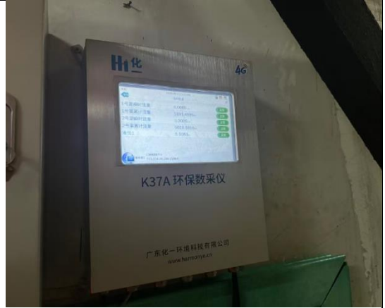
废稀硫酸流量在线记录仪
