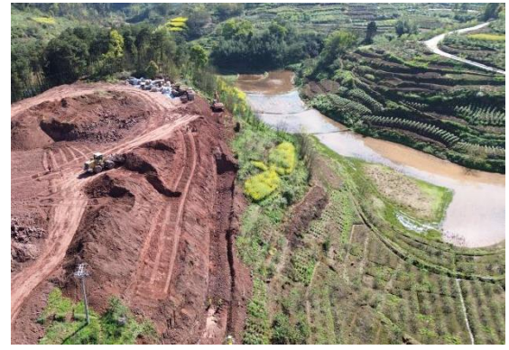
本项目 220kV 变电站拟建站址附近植被
